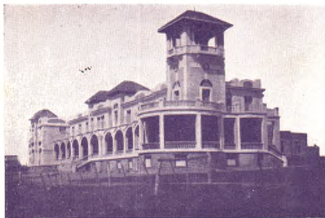
FACHADA PRINCIPAL DEL BIARRITZ-HOTEL
