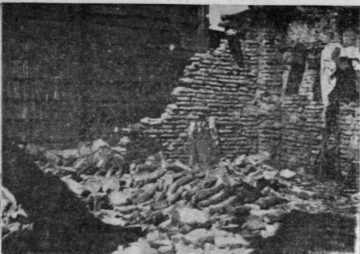
LA PARED DERRUMBADA
