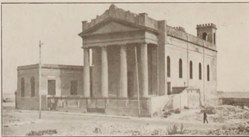
En la actualidad, en vísperas de ser demolido
