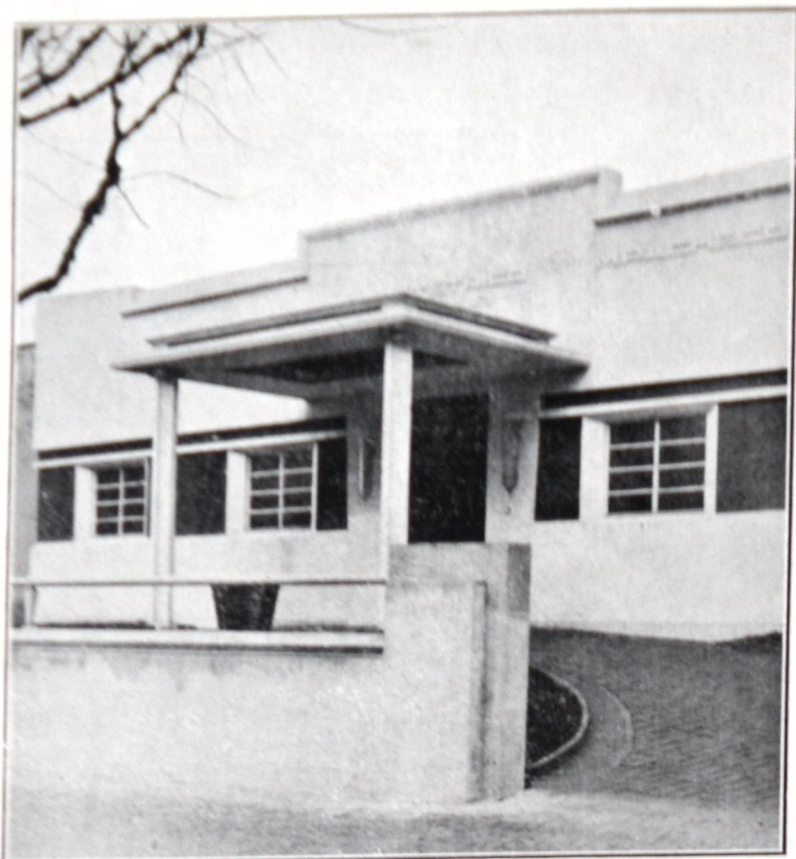
J. A. Rius. Un sanatorio (Detalle de la fachada)
