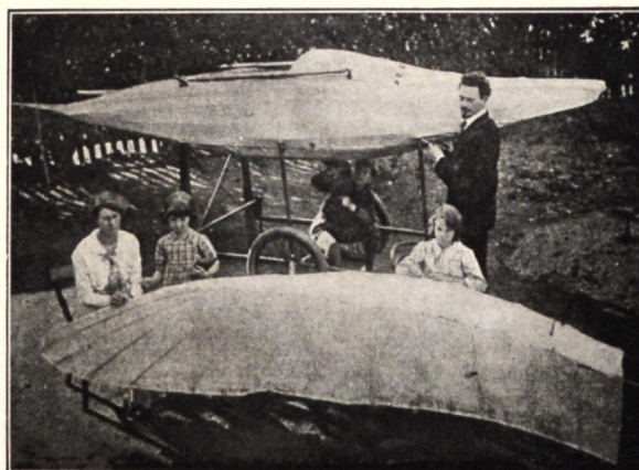
El señor J. B. Passat terminando en familia el "aeroplano-bicicleta sin motor" de su invención con el que ya consiguió dar saltos de 20 metros de largo por 2 metros de alto.
