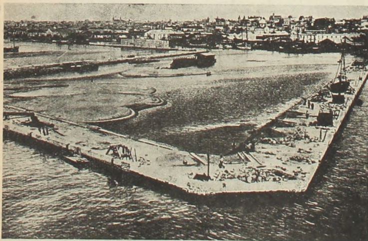
Las primeras obras del puerto: relleno de las dársenas con arena.
