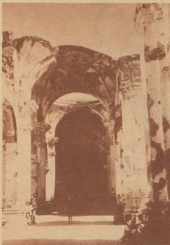
Las huellas del terremoto que instó al traslado definitivo de la capital guatemalteca, se patentizan en esta vista actual de la nave de la primera catedral
