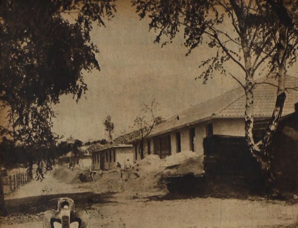
El Pueblo Olímpico construido con material noble ya está terminado, en esta foto nos muestra el balastro pronto para hacer los caminos
