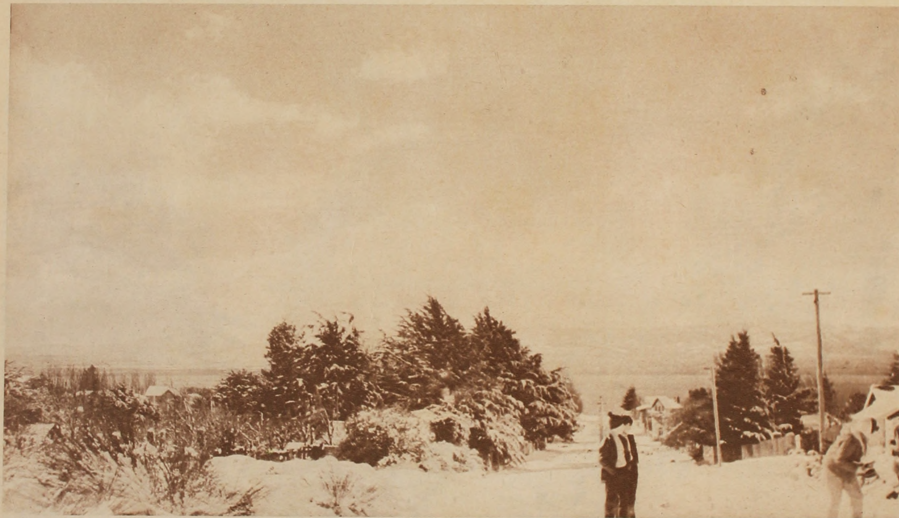
Barrio Obrero Lera. Está situado a la vera del Aº Ñireco y a 1 Km. al sur de San Carlos de Bariloche
