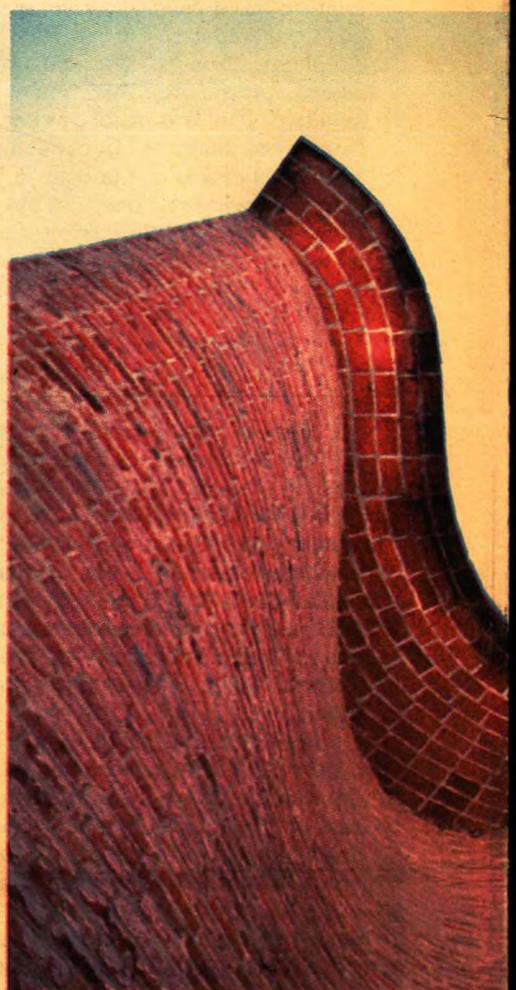
El exterior de la iglesia de Atlántida, donde se aprecia la doble curvatura atirantada que permiten una excelente iluminación durante el día. Así ha dado soluciones a mercados, hangares, silos y terminales de ómnibus en Brasil y Uruguay.
