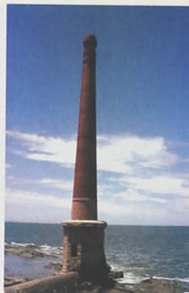
Chimenea de ventilación de la antigua red de saneamiento
