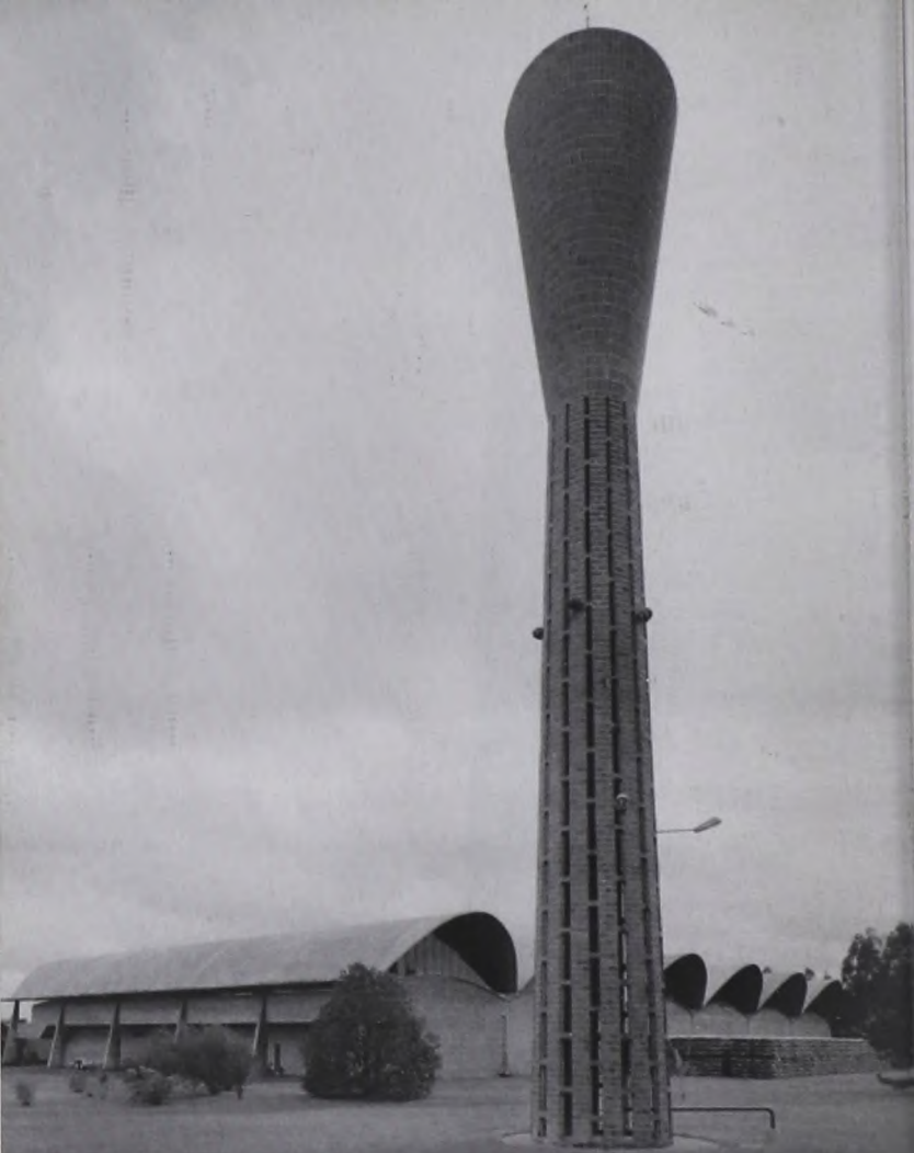
Foto 2 - Tanque de agua de Refrescos del Norte en Salto
