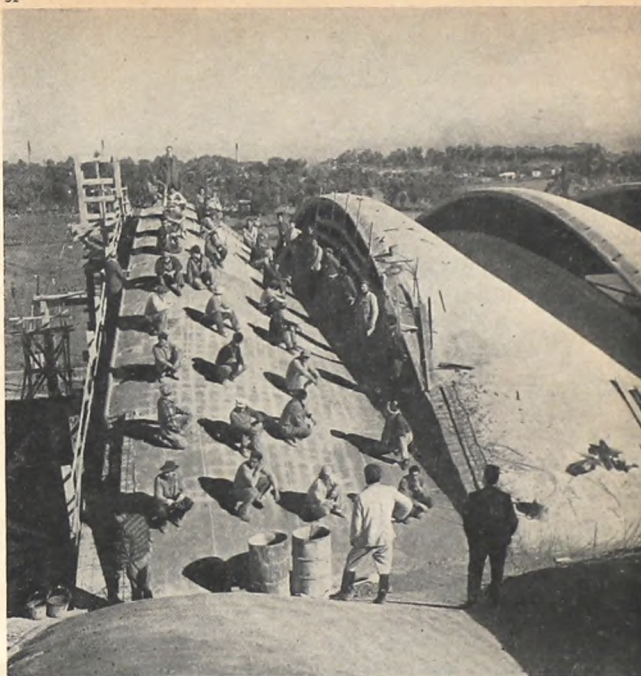
31/32 Mercado de Porto Alegre. 31 Prueba de carga. 32 Vista general, en primer plano pabellón de productores, detrás los pabellones de comerciantes
