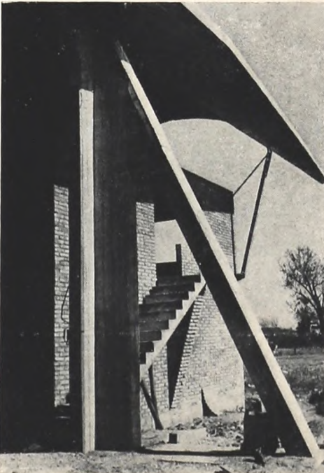
54 a 60 Planta para la empresa Massaro SA, Joanicó, Uruguay. 54 Zona de acceso, bóvedas autoportantes precomprimidas. 55 Bóvedas sobre zona de descarga, sostenidas por una única hilera de pilares. 56 Vista previa a la construcción de muros laterales. 57 Superposición de bóvedas de distintas alturas, zona de descarga. 58 Depósito. 59 Pilar de borde del techo sobre zona de descarga. 60 Acceso y administración. (fotos Arana)
