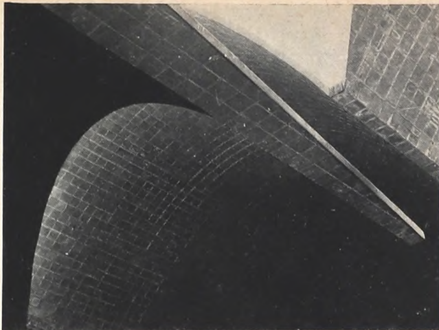
54 a 60 Planta para la empresa Massaro SA, Joanicó, Uruguay. 54 Zona de acceso, bóvedas autoportantes precomprimidas. 55 Bóvedas sobre zona de descarga, sostenidas por una única hilera de pilares. 56 Vista previa a la construcción de muros laterales. 57 Superposición de bóvedas de distintas alturas, zona de descarga. 58 Depósito. 59 Pilar de borde del techo sobre zona de descarga. 60 Acceso y administración. (fotos Arana)
