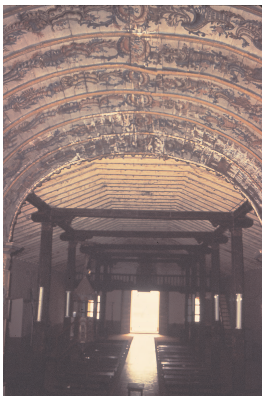
Interior da igreja da Virgem da Candelária de Capiatá, Paraguai. Forro de madeira da capela-mor
