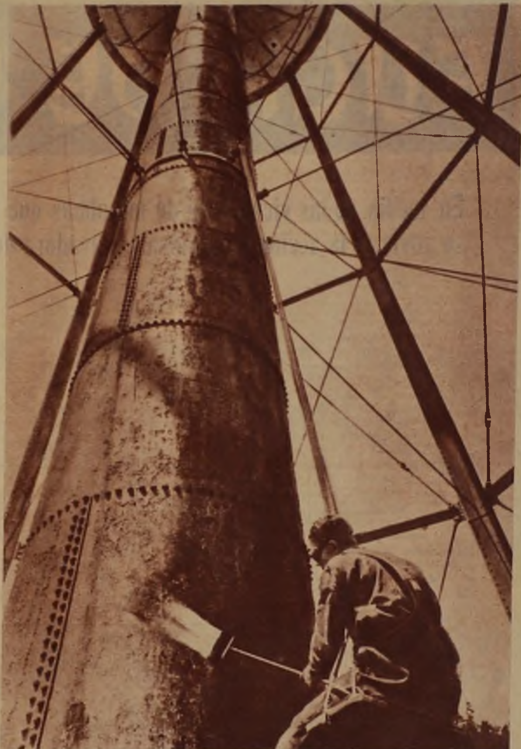
Este procedimiento de limpieza y deshidratación a fuego se emplea para preparar una superficie a fin de ser repintada. En este método, superior a cualquier otro para tal clase de labor se emplea una mezcla de oxígeno y acetileno.
