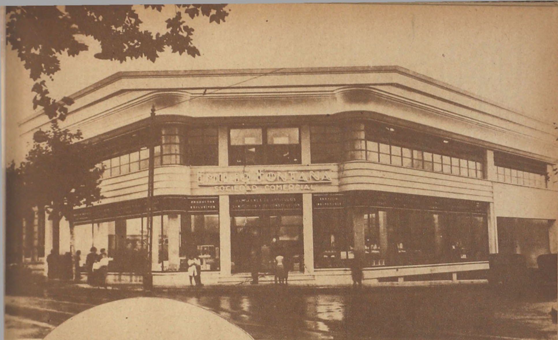
FACHADA del moderno edificio de la Casa Emilio Fontana Sociedad Comercial. La iluminación de esta fachada y del interior, fueron realizadas por la casa "Pierro Hnos."
