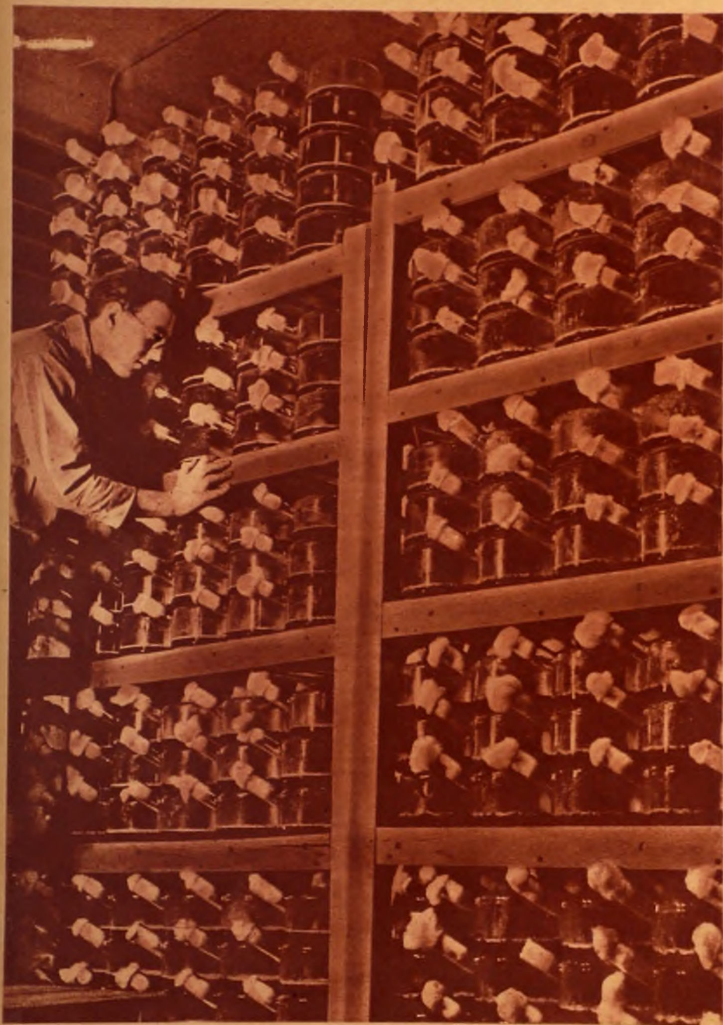
En cada uno de estos frascos se fabrica una dosis de 15.000 unidades de penicilina, debiendo esperarse tres semanas para que sea extraída pura. Luego, una parte va a los frentes de guerra; otra es transportada a los laboratorios de investigación para seguir estudiando sus efectos frente a los gérmenes que ha de combatir.
