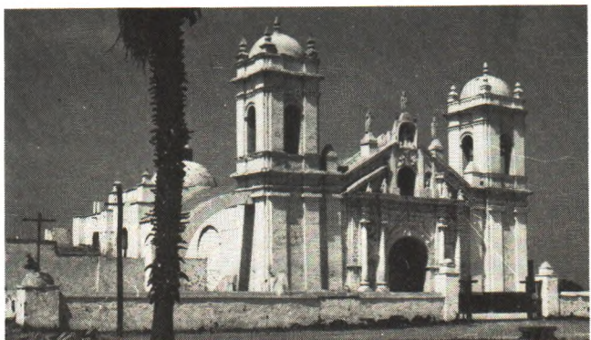
Estado de la Iglesia de Santiago de Huamán antes del temblor de tierra de 1970.
