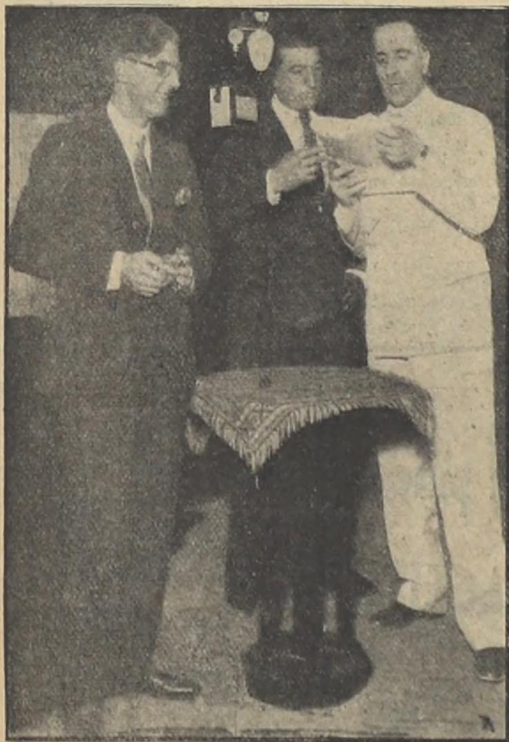
En la sala de transmisiones de la Westinghouse, Blanco y Pereda conversando con nuestro cronista Perelló, en el reportaje que éste les hizo ante el micrófono.
