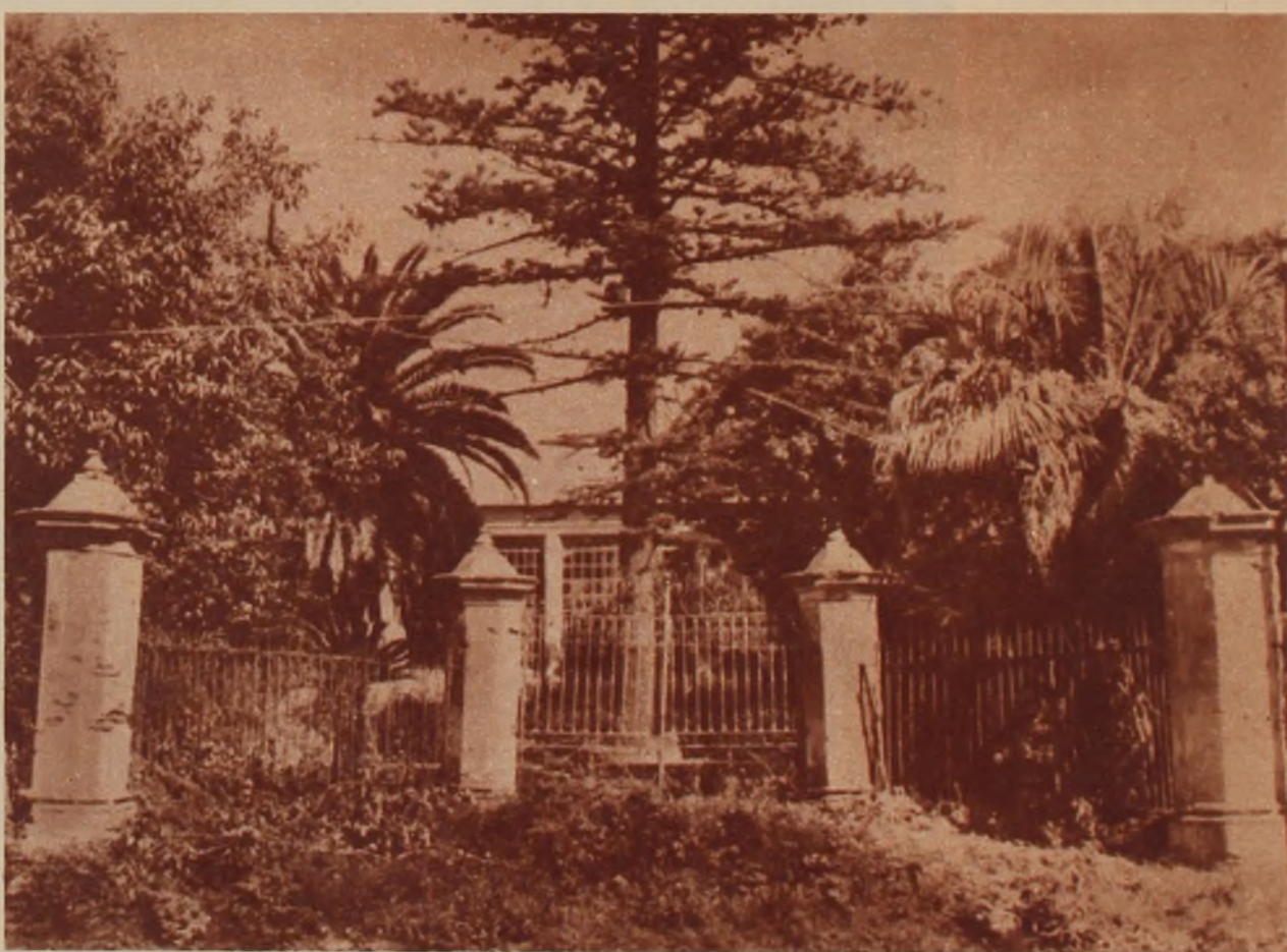
La casa-quinta que fuera del jurisconsulto Dr. Joaquín Requena. Hoy es sede de una fábrica de cintas.
