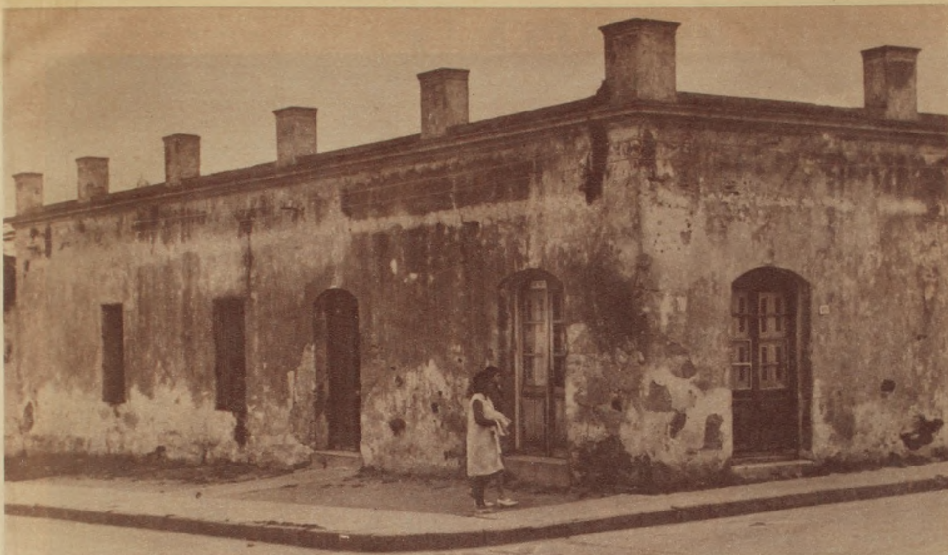
Calle Leonardo Olivera esquina Carlos Reyles: ángulo del Museo antes de iniciarse, a fines de noviembre del año pasado, los trabajos de restauración
