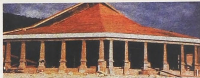
La clínica de marras, en obras.
