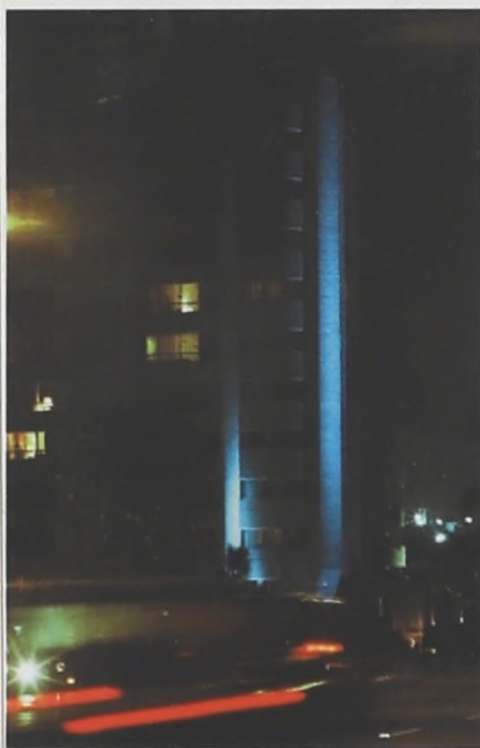
Edificio en la Rambla República del Perú.
