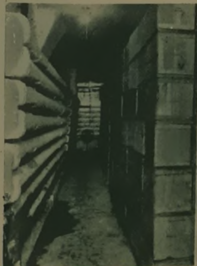
En este depósito un ventilador hace circular el aire por entre los cajones de huevos, los cuales (los cajones) están separados por listones
